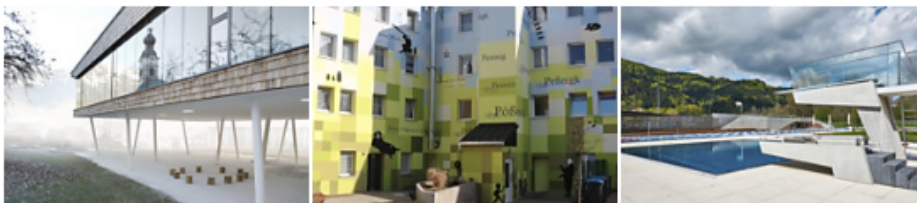
KREINERarchitektur ZT Kindergarten Ennstal »
