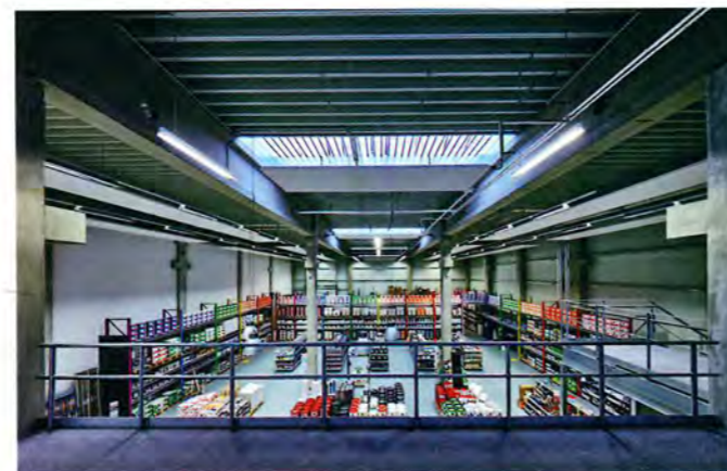
Bild 5. Durch die Verteilung der tragenden Konstruktion wird eine flexible Einteilung in Hallensegmente ermöglicht
