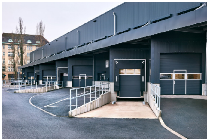
4 Einfahrten der vier vorderen Hallenabschnitte
